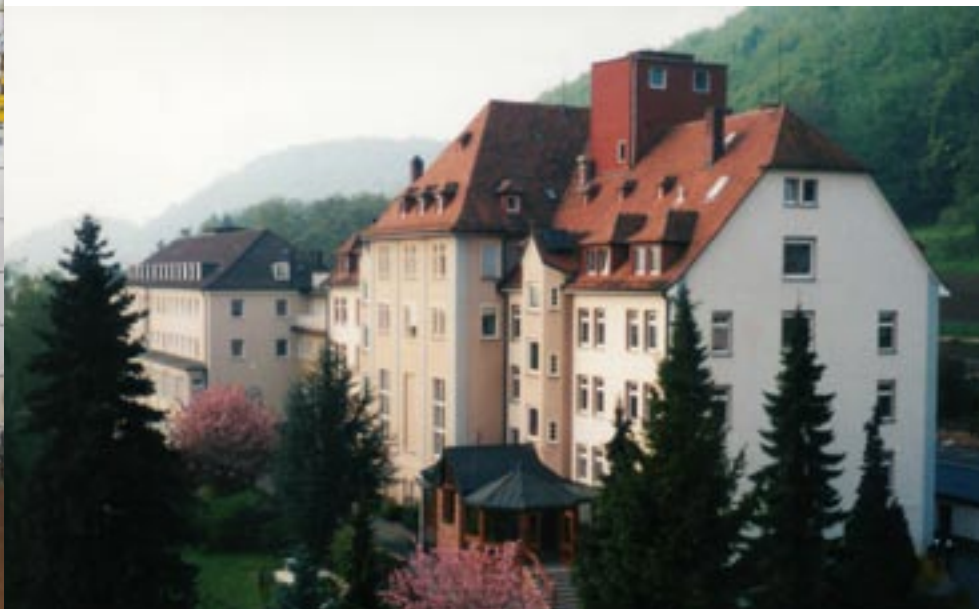
Das Diakonissen-Mutterhaus in Marburg-Wehrda wird jetzt komplett von einem Nahwärmeverbund versorgt. Der besteht aus zwei Blockheizkraftwerken, mehreren Buderus-Heizkesseln und einem neuen Fernwirsystem zur Überwachung und Regelung der Anlage.
