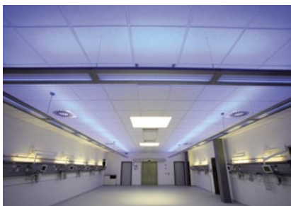
Bilder 2 bis 4. Die U-förmig angeordneten Leuchten BlueMotion von Trilux ergänzen die Allgemeinbeleuchtung im Aufwachraum (Foto: Trilux)
